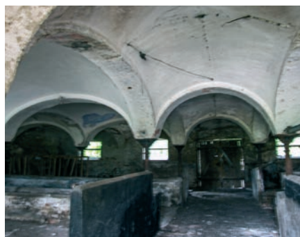
Das denkmalgeschützte Gewölbe des Klosterwirt-Stadls: Wir sind dafür, dass hier ansprechend gebaut wird und Nutzungs-Ideen aus der Bürgerschaft umgesetzt werden.
